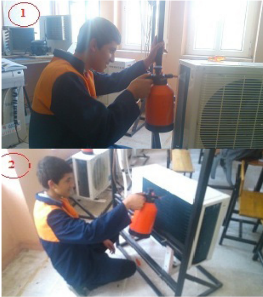
Şekil 4. Dış Ünite Bakımı İşlem Basamakları
