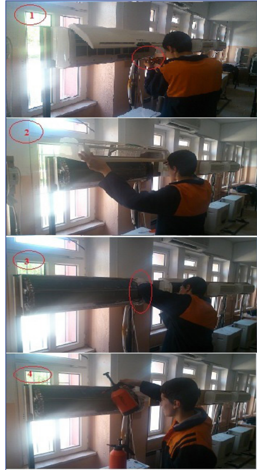
Şekil 2. İç Ünite Bakımı İşlem Basamakları
