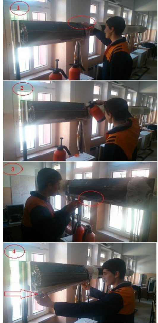
Şekil 3. İç Ünite Bakımı İşlem Basamakları
